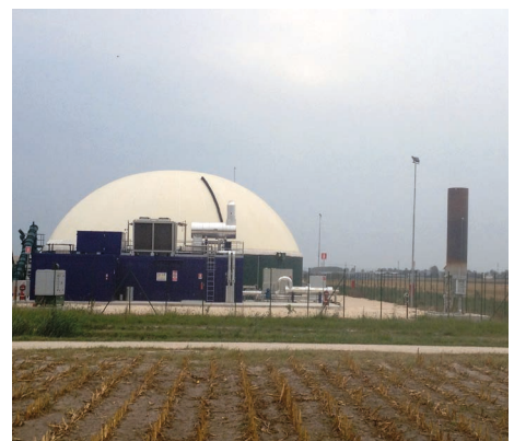
Cogeneratore ad alto rendimento, raffreddamento (chiller) e compressione del biogas
