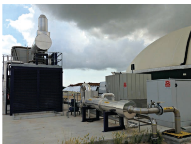
Cogeneratore ad alto rendimento, raffreddamento (chiller) e compressione del biogas
